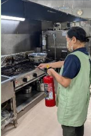
初期消火失敗
